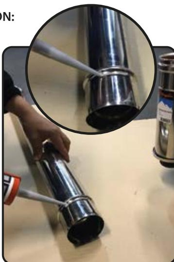
**2.** Aplique un cordón de SILICONA DE ALTA TEMPERATURA GRIS por todo el perímetro un poco más abajo del rodón del ducto.
